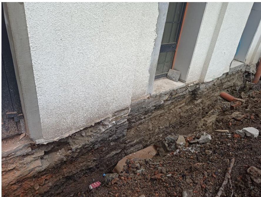
Rys. 49 Częściowo odsłonięty kamienny fundament zachodniej ściany Manufaktury Grossa, na który aplikowano zaprawę uszczelniającą [zdjęcie własne]
