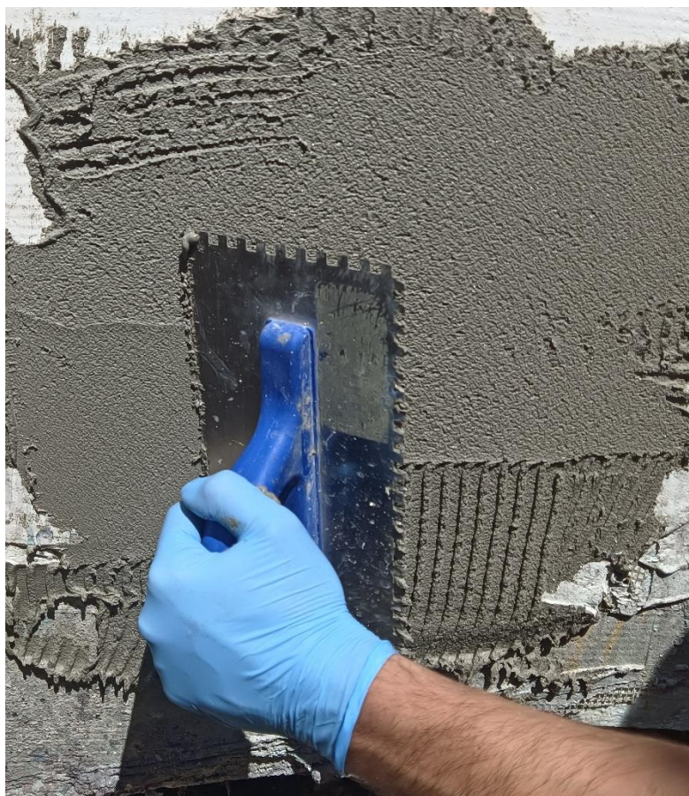
Rys. 46 aplikacja zaprawy uszczelniającej na równym podłożu przy użyciu pacy zębatej [zdjęcie własne]
